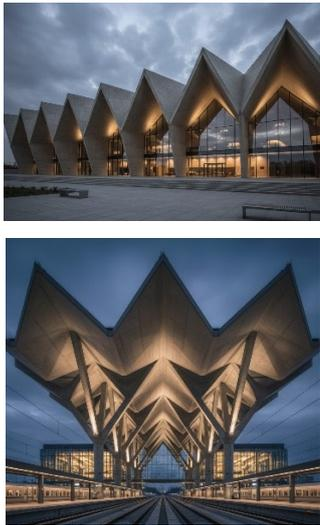
Gambar 4. Contoh Aplikasi Struktur Pelat Lipat (Folded Plate Structures)
